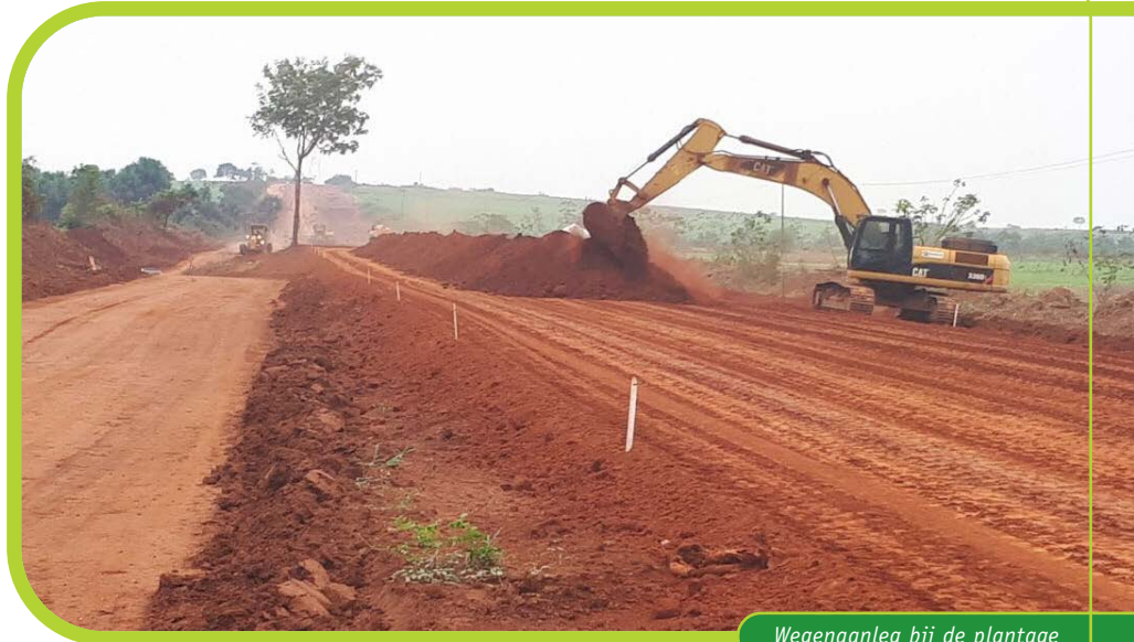
Wegenaanleg bij de plantage
